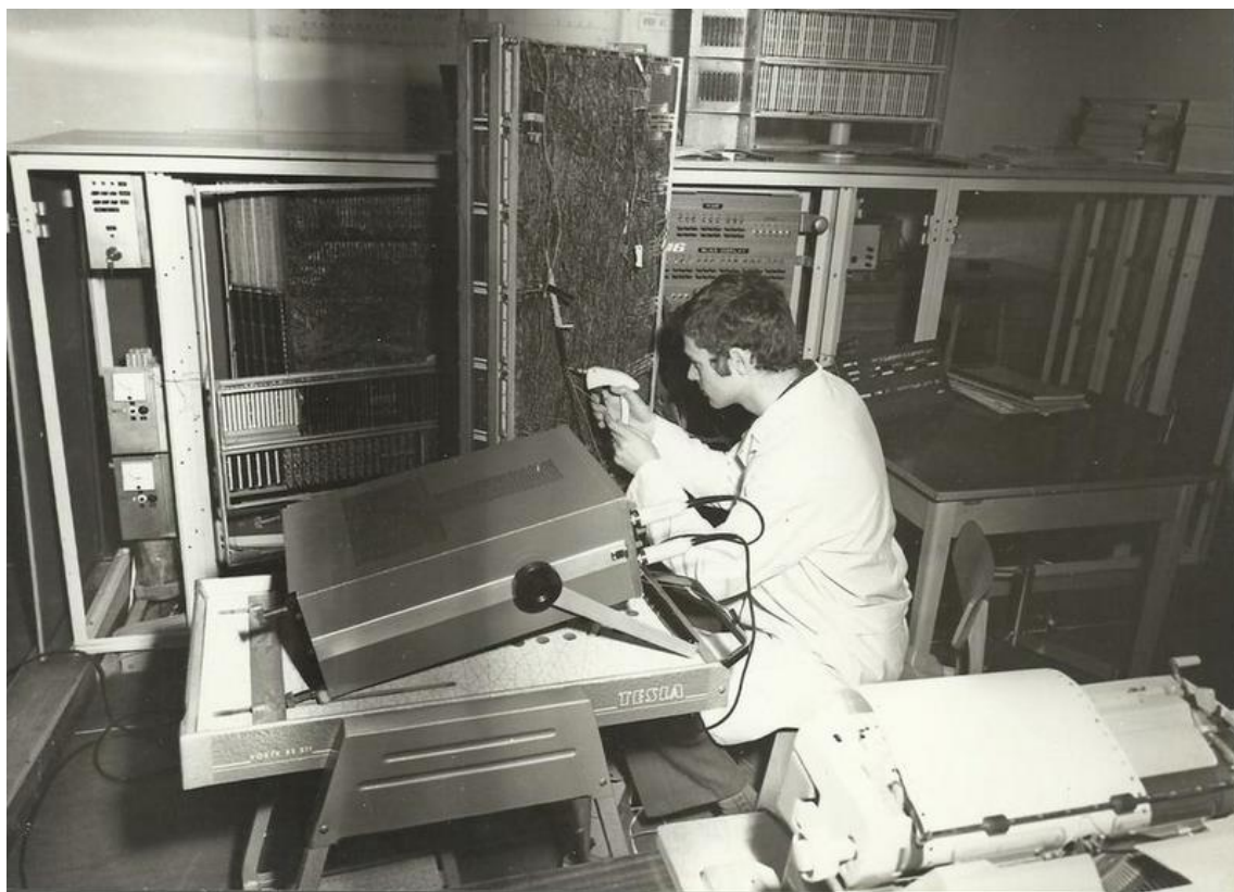
Obr.1: Ing. Peter Podracký pri prepájaní dosiek plošných spojov pomocou drôtov a ovíjacej pištole vo VVL Žilina na Nešporovej ulici (foto z archívu Ing. Vincenta Škottu) Po tretie by som chcel spomenúť úlohu komunistckej strany pri projekte RPP-16.
